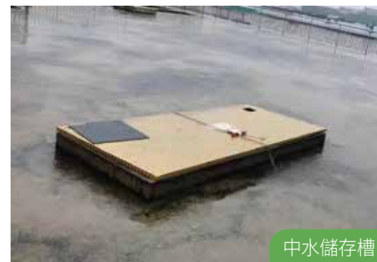
中水處理設備
